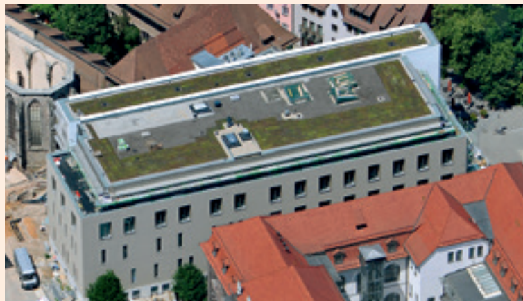
Abb. 4.11: Dachbegrünung in der Altstadt, Nonnengarten- straße
