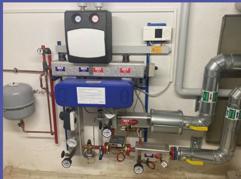
Fernwärme-Übergabestation: »Ich hänge an der Wand und halte die Klappe.«
