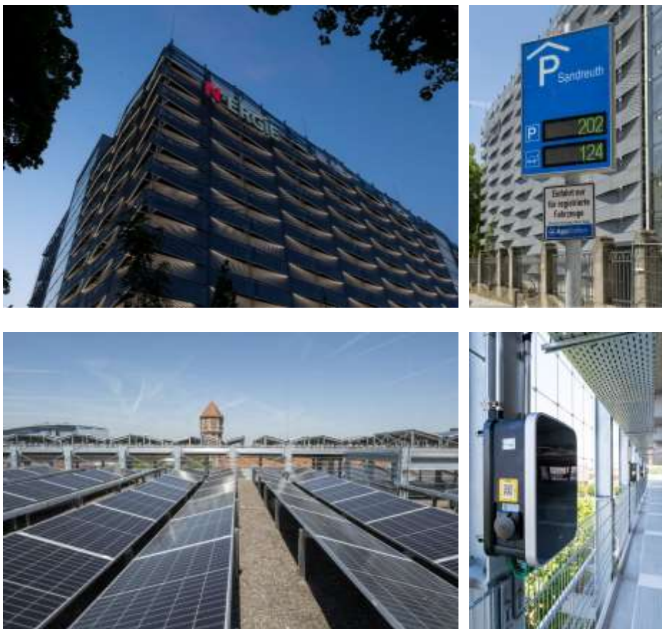
Parkhaus der Zukunft der N-ERGIE: (Foto: N-ERGIE - Ekkehard Winkler)
