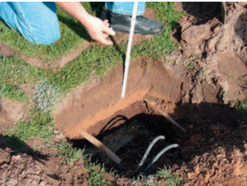
Das Foto von Landschaftsgärtner Thomas Müller zeigt Aufbau und Schichten des Rollrasens mit den Röhren für Rasenheizung und Beregnung (oben).
