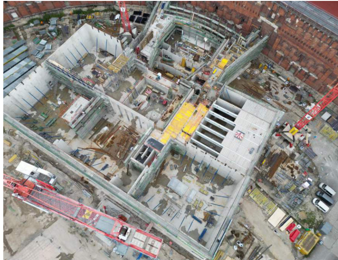
Ergänzungsbau des Staatstheaters im Innenhof der Kongresshalle
