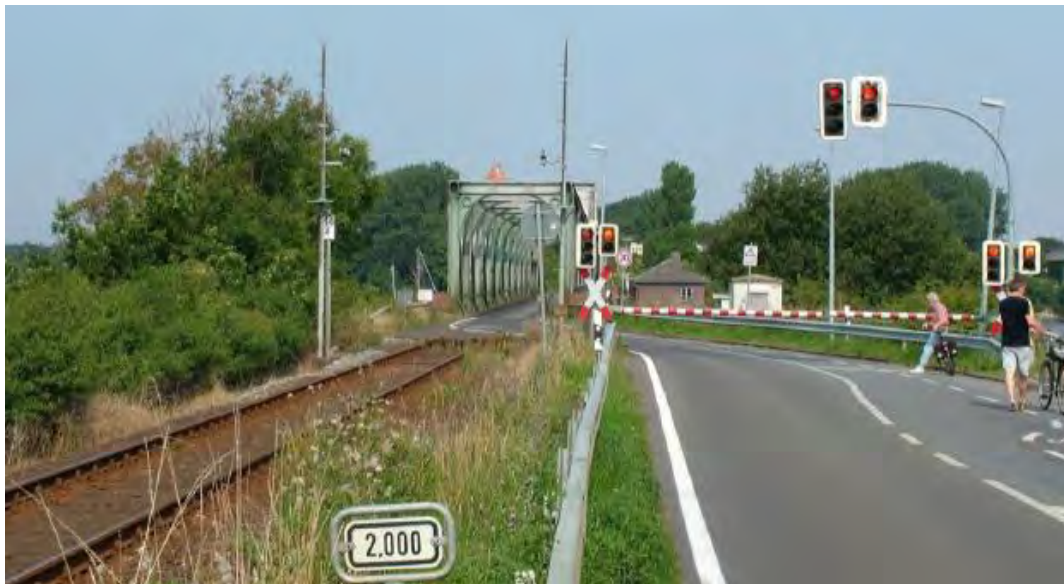
Abbildung 17: Schrankengeregelte Mischnutzung der Eisenbahnbrücke bei Lindaunis
