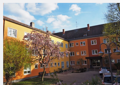
Senioren-Wohnanlage St. Johannis (Foto Ulrich Matz)
