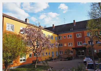
Senioren-Wohnanlage St. Johannis (Foto Ulrich Matz)
