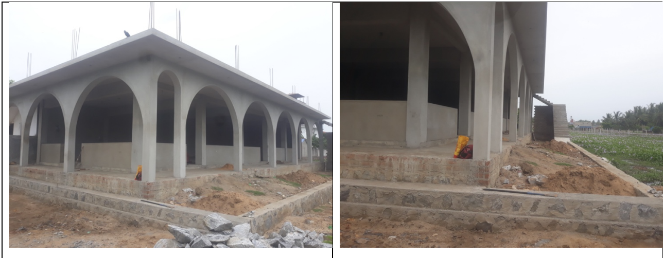
Bilder: August 2020 – die erste Hälfte des zweistöckigen Gebäudes ist fertig gestellt.
