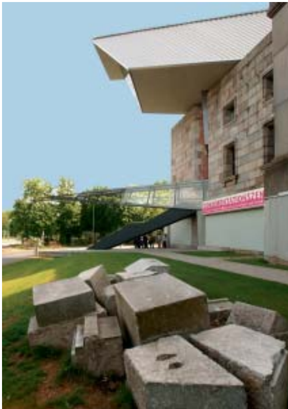
Der Eingang zum Dokumentationszentrum Reichsparteitagsgelände im nördlichen Kopfbau der Kongresshalle: Architekt Günther Domenig hat mit seinen Ein- und Aufbauten eine eigene Sprache im Umgang mit dem historischen Bauwerk gefunden.
