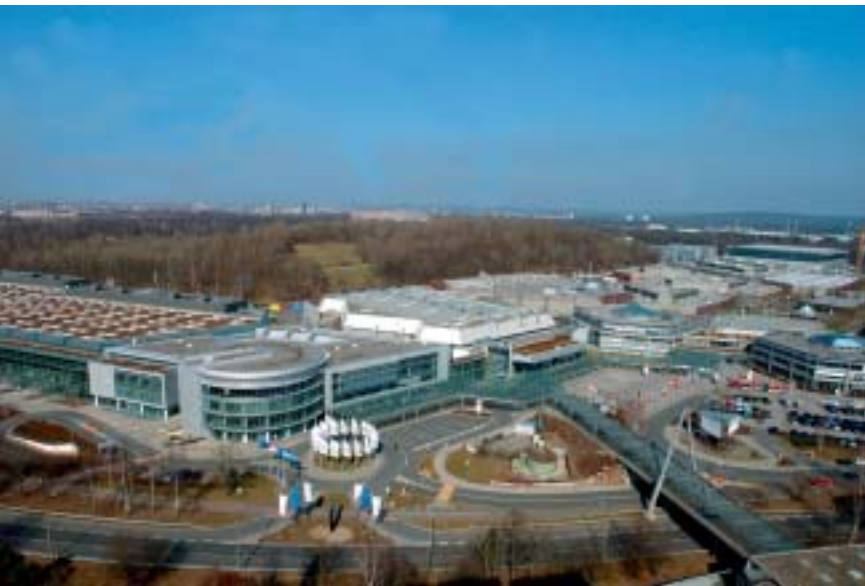
Blick auf die NürnbergMesse vor dem Silberbuck (oben).
