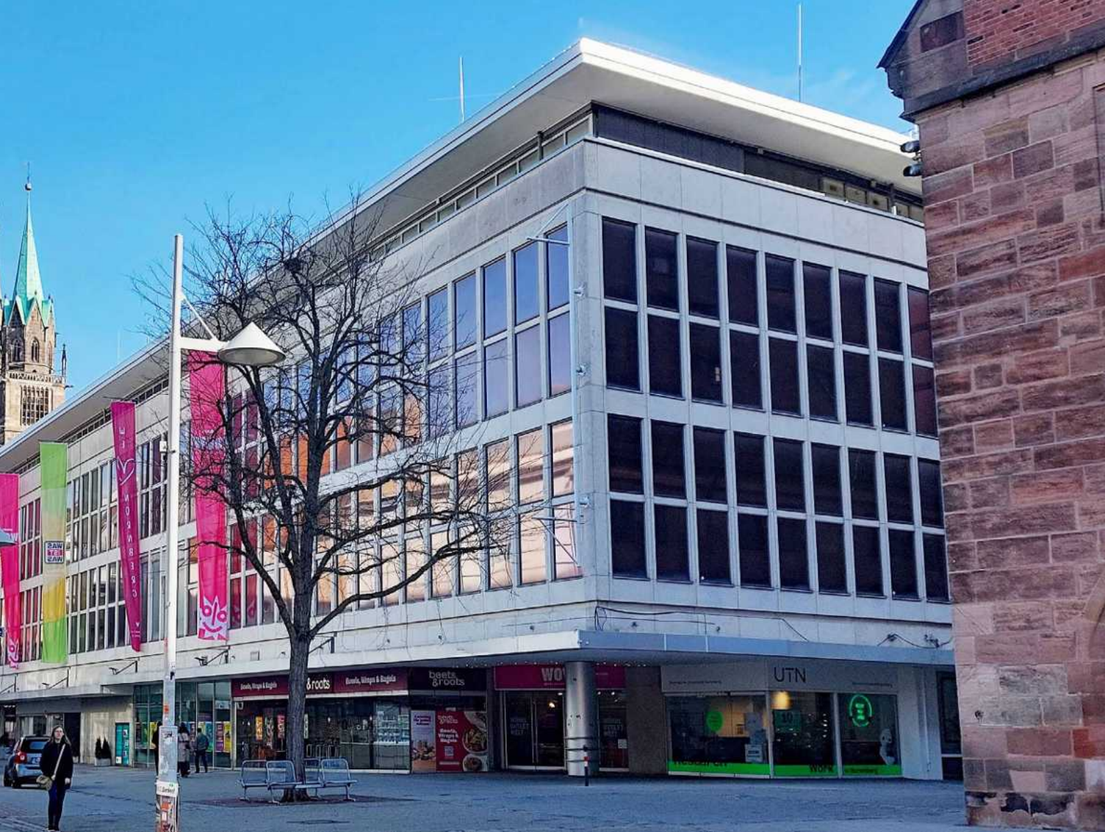
43 Zwischennutzung des ehemaligen Kaufhofgebäudes durch ein Pop up Projekt
