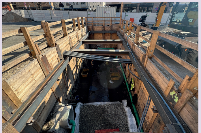
Baustellenalltag am Obstmarkt: Hier wird im wahrsten Sinne des Wortes tiefgründig gearbeitet. Bei den Arbeiten im Untergrund ist auch die Stadtarchäologie eng eingebunden. - Foto: André Winkel
