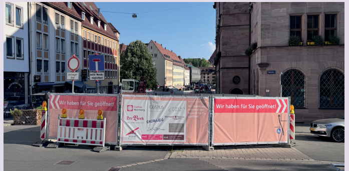
Auch während der Bauzeit sind die Geschäfte für die Kundschaft da. Bauzaunplakate machen sichtbar: Hier wird gebaut – aber weiterhin eingekauft, beraten und bedient. - Foto: André Winkel
