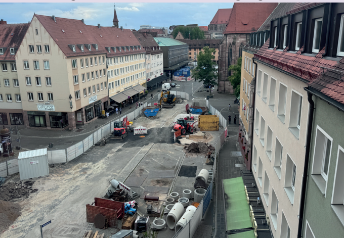
Noch prägen Baugruben, Maschinen und Material den Obstmarkt. Der Blick aus dem Rathausfenster zeigt: Bis der neue Platz fertig ist, gibt es noch einiges zu tun. - Foto: André Winkel
