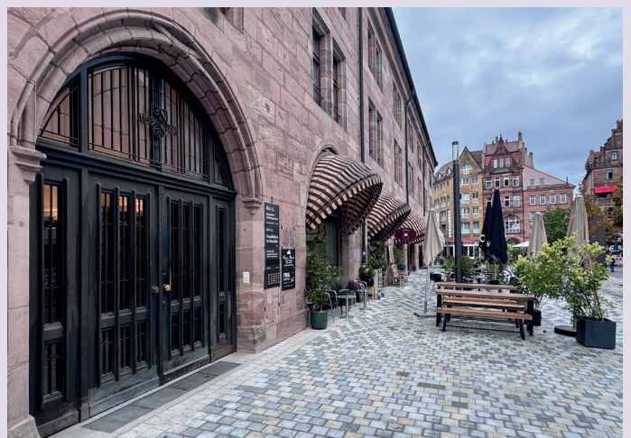
Das angehobene Granitpflaster ermöglicht die barrierefreie Erreichbarkeit der Gebäude. - Foto: André Winkel
