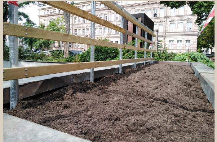
Das Rankgerüst im kleineren Beet dient gleichzeitig als Absturzsicherung. Jetzt kann auch hier bepflanzt werden - Foto: QM Altstadt
