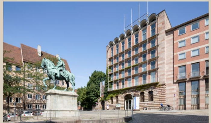
Soll zum „Haus des Spiels“ werden: das Pellerhaus am Egidienplatz - Foto: Stefan Mayer
