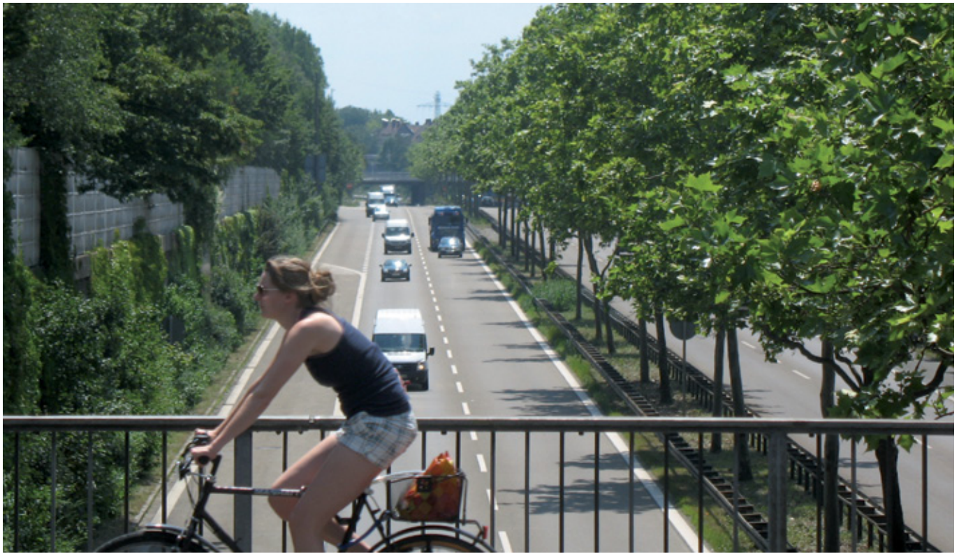
Fußgänger- und Fahrradbrücke über den Frankenschnellweg.
