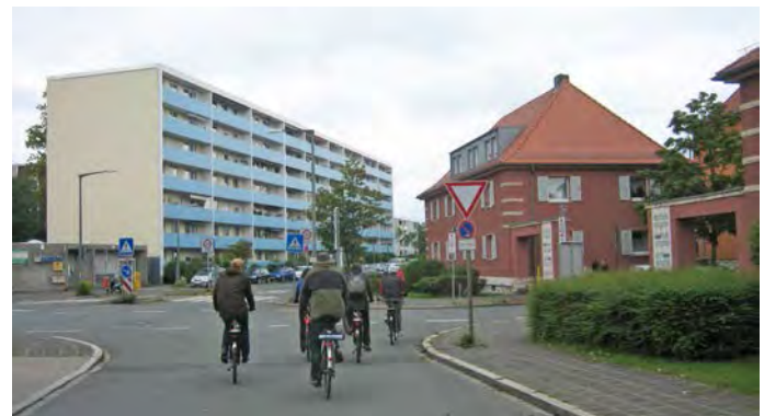
Hochpunkte und Zeilen in Neuselsbrunn
