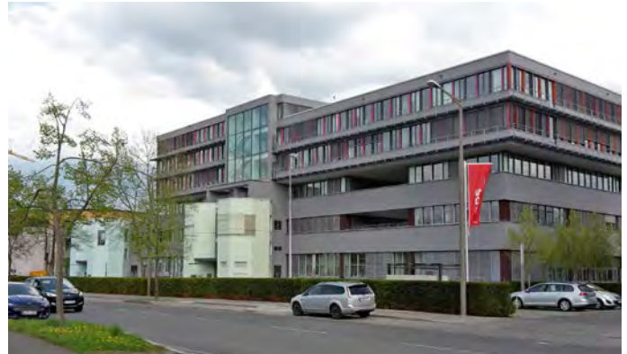
Neubau Bankgebäude und Sanierung der Grundig-Türme
