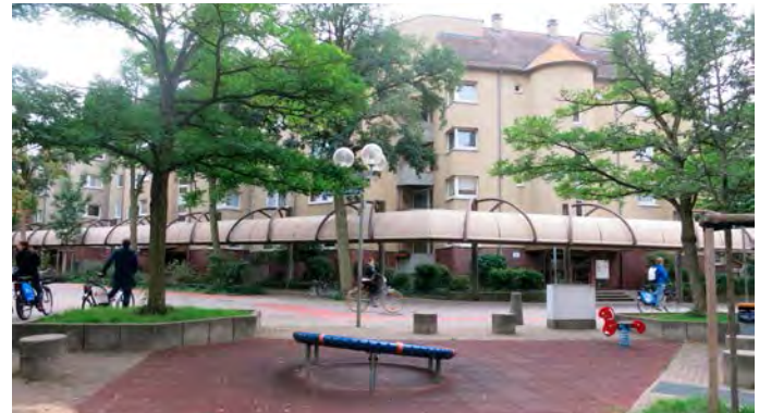
Rangierbahnhof- und Planetenringsiedlung
