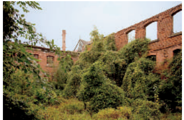
... und die restlichen Bauruinen.
