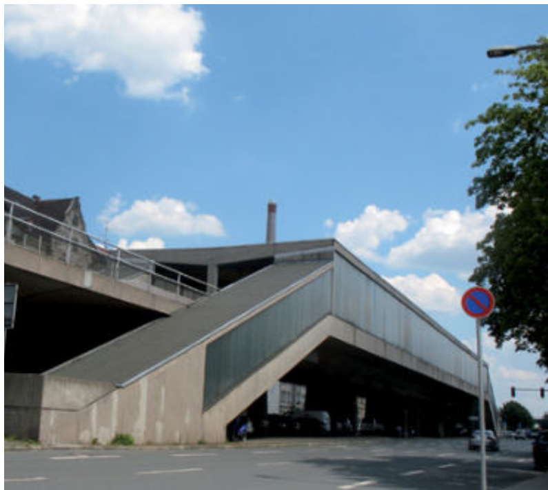
U-Bahn Haltestelle „Muggenhof“ auf der Fürther Straße.
