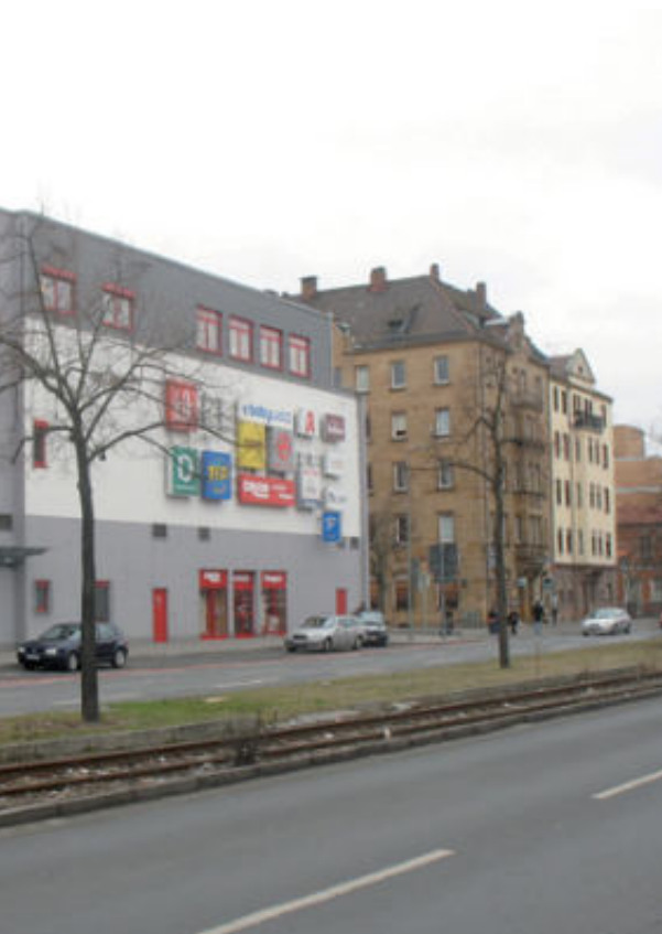
C-Zentrum Eberhardshof mit Admira Center .
