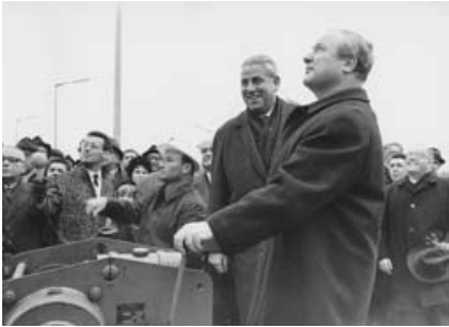
Beginn der Bauarbeiten für die Nürnberger U-Bahn 1967
