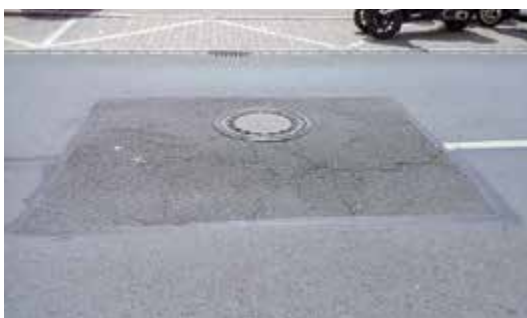
Straßenbaumaßnahme mit Mängelanspruch: Die mangelhafte Deckschicht wurde durch eine neue, mängelfreie Deckschicht ersetzt.
