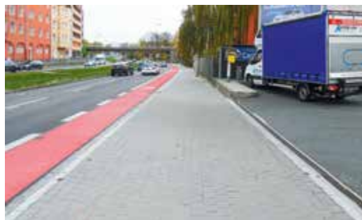
Der Radweg an der Erlanger Straße nimmt Gestalt an.
