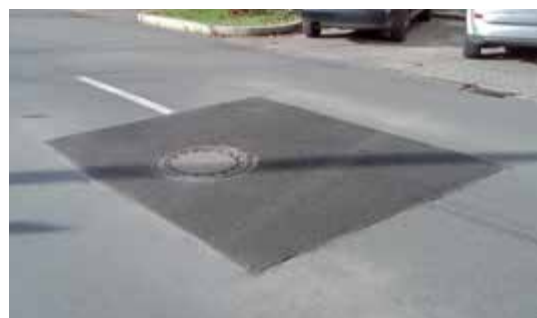
Straßenbaumaßnahme mit Mängelanspruch: Die mangelhafte Deckschicht wurde durch eine neue, mängelfreie Deckschicht ersetzt.
