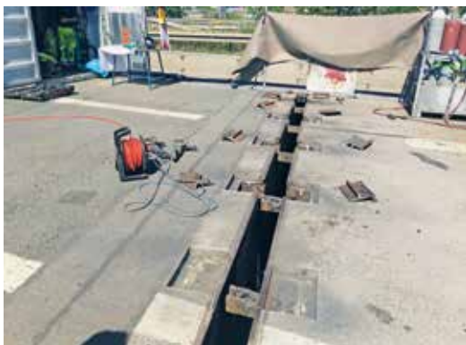
4. Endlich konnte der Austausch beginnen: Ausbau der alten Übergangskonstruktion.
