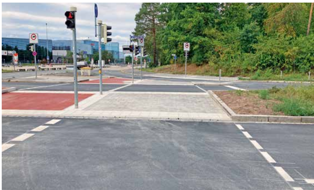
Die Überquerungshilfen über die Karl-Schönleben-Straße wurden sowohl für den prognostizierten Radverkehr als auch sehbehindertengerecht ausgebaut.
