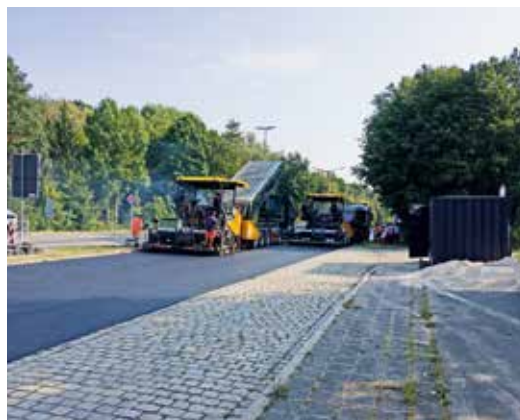
Fertiger Deckeneinbau in der Äußeren Bayreuther Straße.
