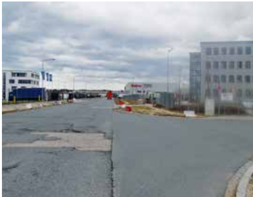
Koperstraße: Der Einbau der Asphaltdeckschicht war dringend notwendig.
