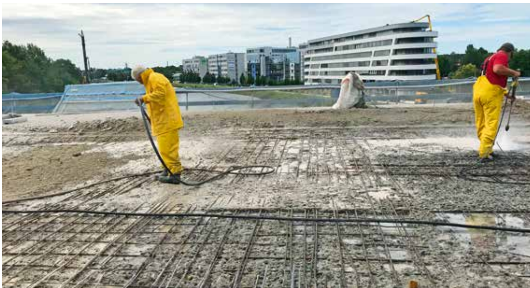
Reinigung der Brückentafel.
