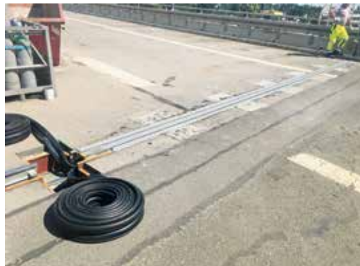
6. Einbringen der Dichtungsprofile.
