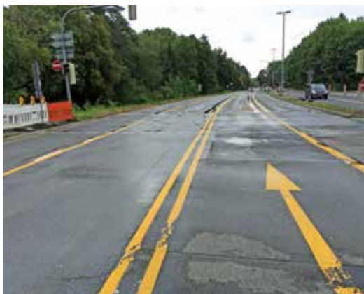
Äußere Bayreuther Straße in Blickrichtung stadtauswärts.
