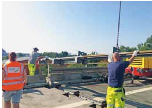
5. Einheben der neuen Übergangskonstruktion.
