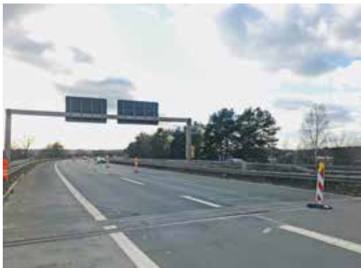
3. Die unmittelbar betroffenen rechten Fahrspuren wurden sofort gesperrt.
