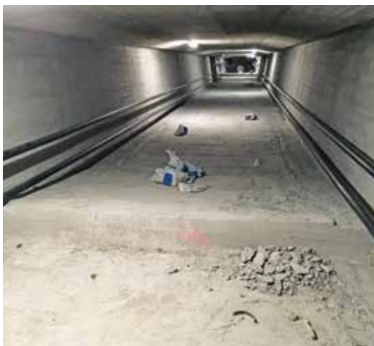
Blick in einen Hohlkasten der Charles-de-Gaulle-Brücke.
