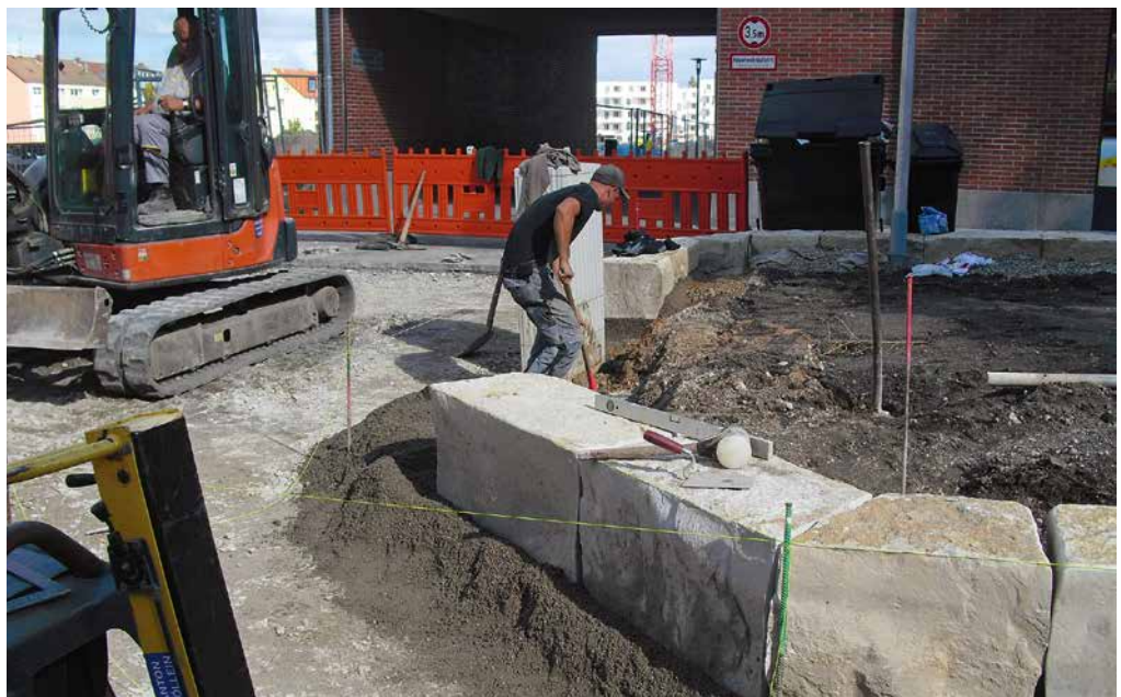
Straßenbauarbeiten am Schillerpark
