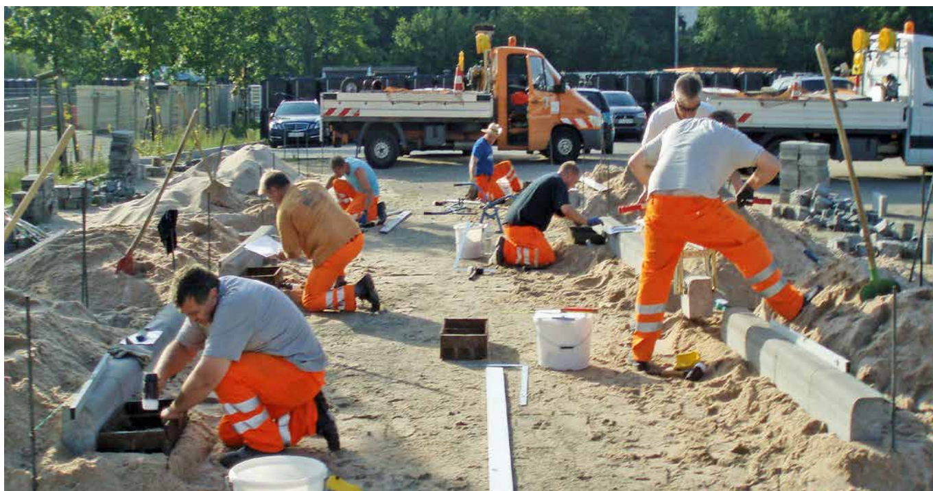
Mitarbeiter am Prüfungstag beim Setzen von Betonrandsteinen
