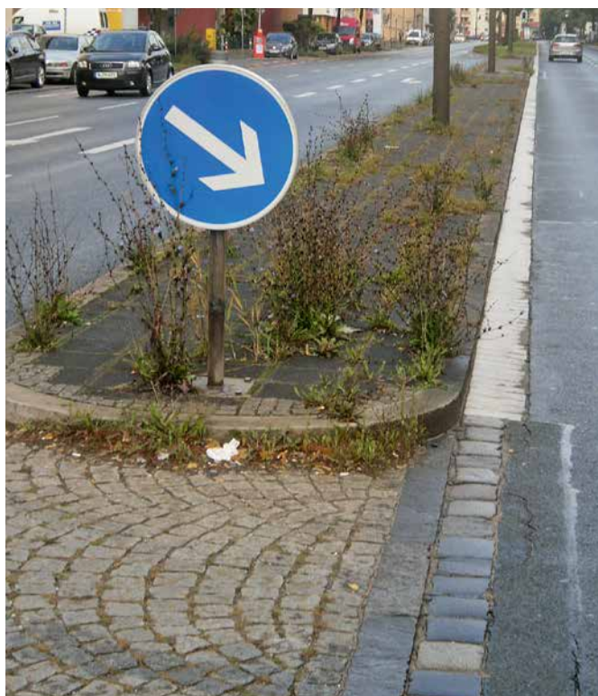
Welser Straße - Verwahrloster Anblick vor der Sanierung
