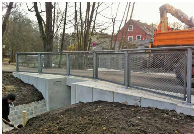
Neues Bauwerk 2014 nach der Fertigstellung
