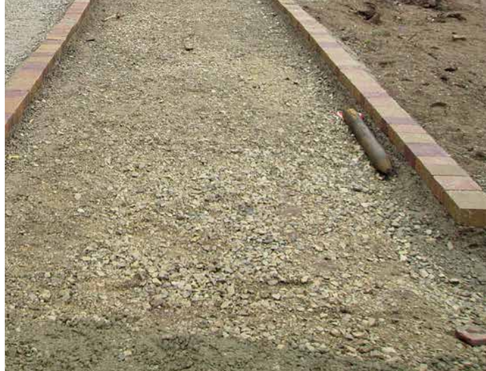
Baustellenbetrieb an der Jülicher Straße
