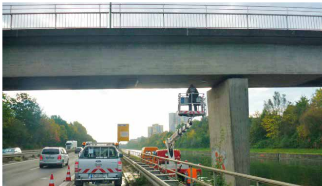
Brückenbauwerksüberprüfung
