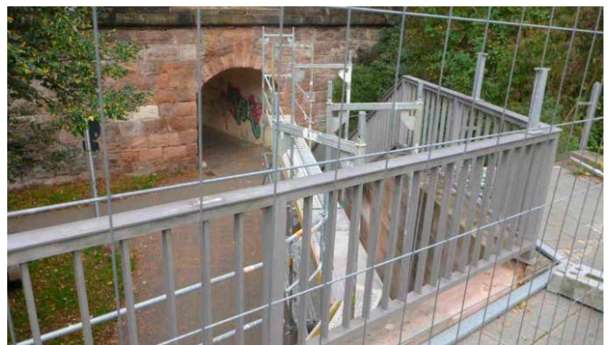
Sanierung Sandsteinmauer und Treppenanlage
