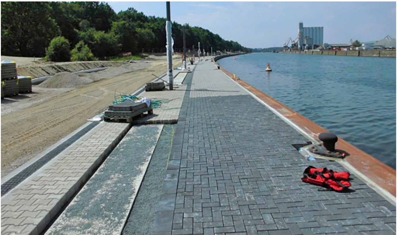
Die ersten Anlegestellen sind nahezu fertiggestellt
