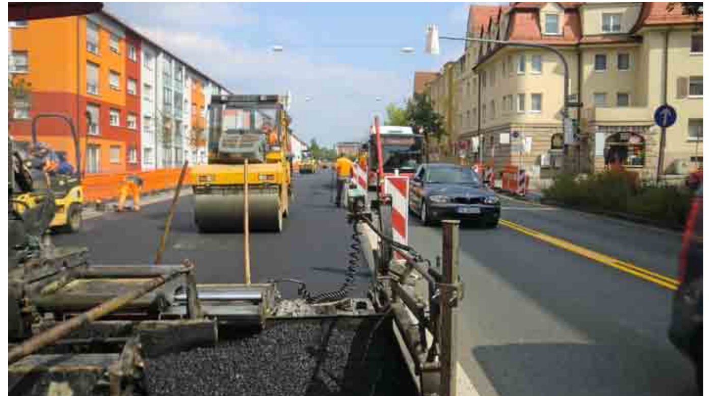
Einbau in der Frankenstraße
