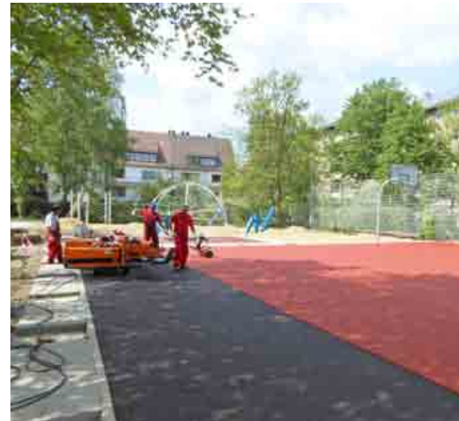
Kunststoff-Belag Ballspielfeld im Bau
