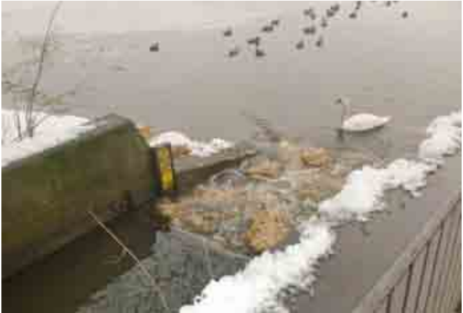
Februar 2013 Großer Dutzendteich, Einlauf Langwassergraben Durchgängigkeitsverbesserung
