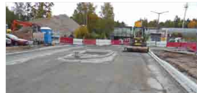
Baustelle Fußgängerinsel Löwenberger Straße
