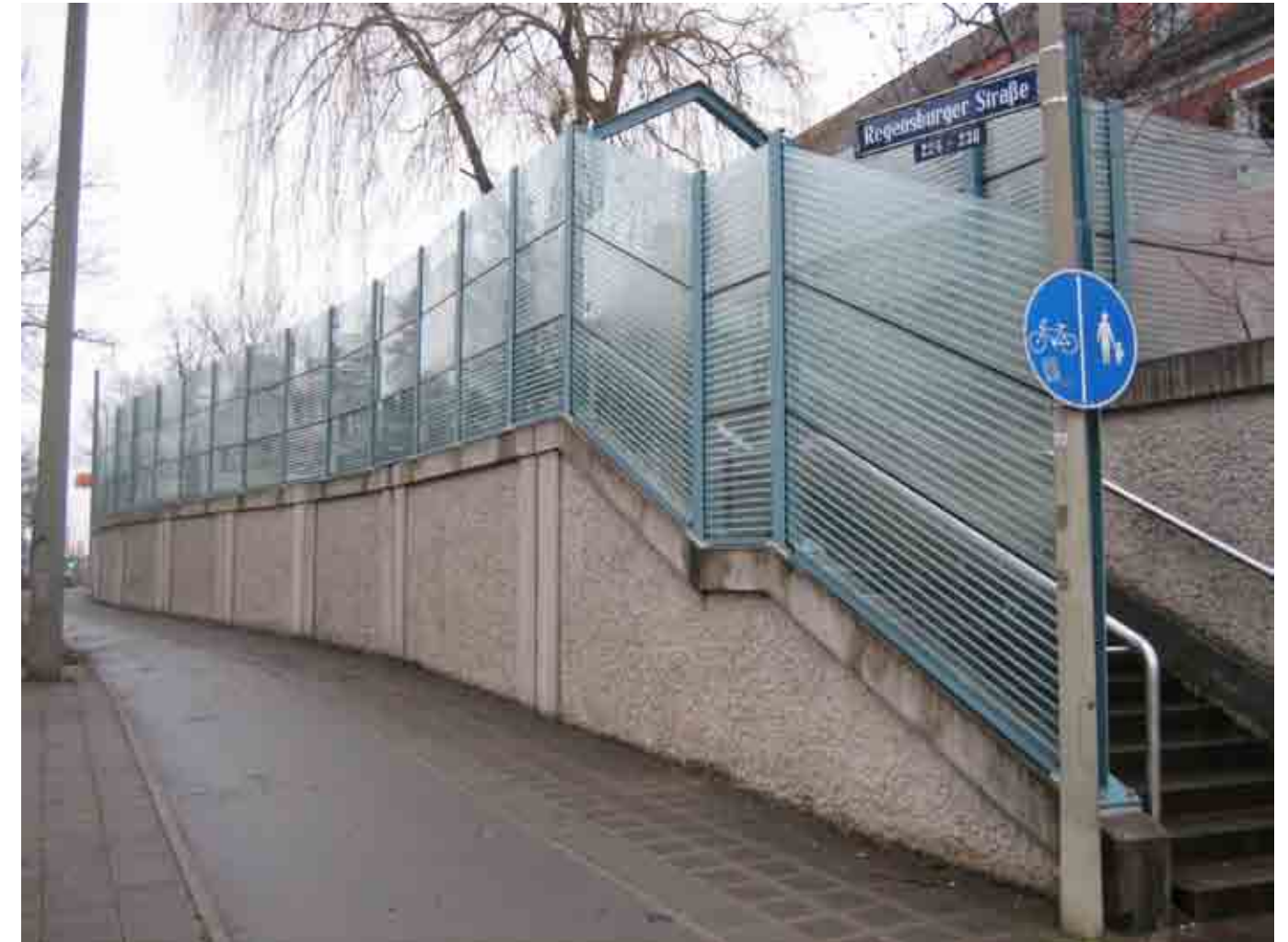
Lärmschutzwand Regensburger Straße
