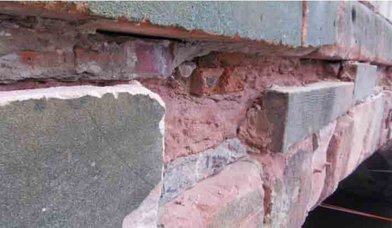
Die Untere Karlsbrücke vor der Sanierungen 2012. Die Schäden am Mauerwerk sind klar ersichtlich.
