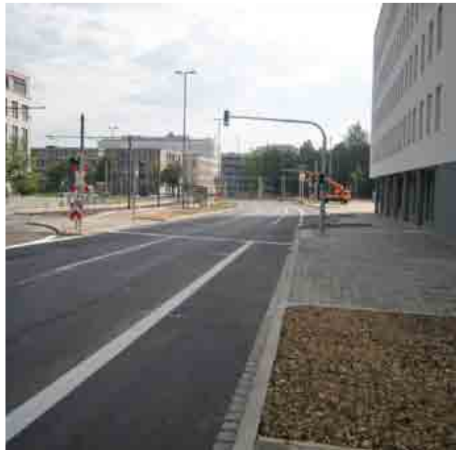
Bahnhofstraße Blickrichtung Wöhrder Talübergang – fertiggestellt
