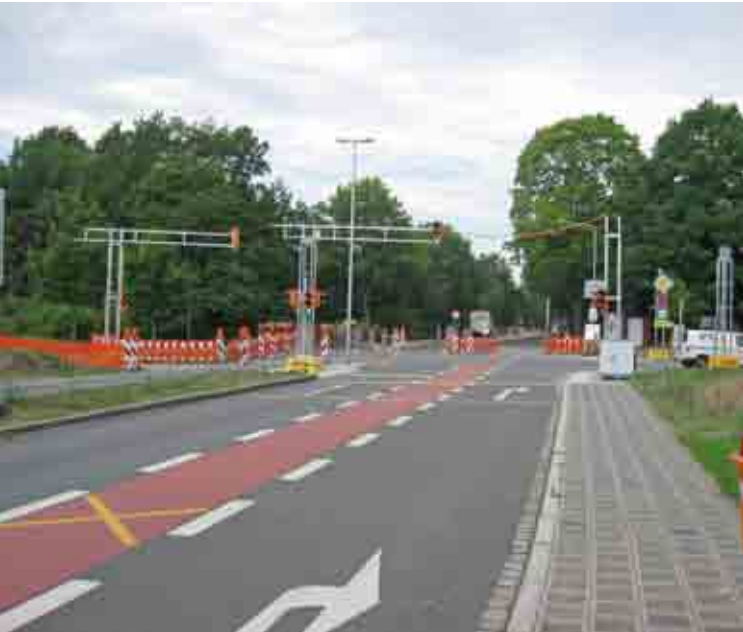
Ein anderes Beispiel: Baustellen-Absperrungen und mobile LSA während des Umbaus der Marienbergstraße
