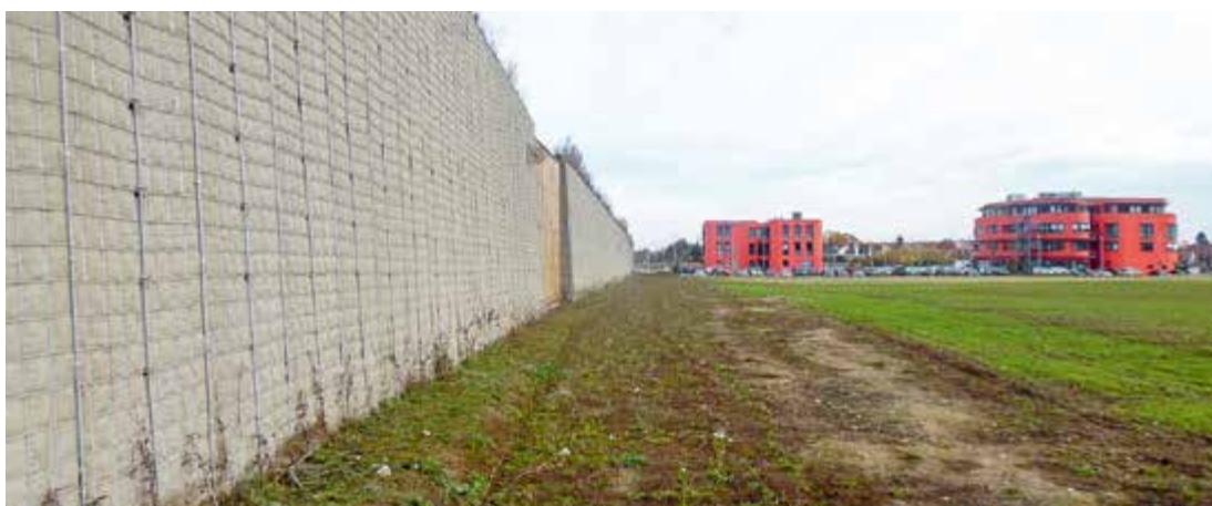
Lärmschutzwände schützen die Anlieger.
