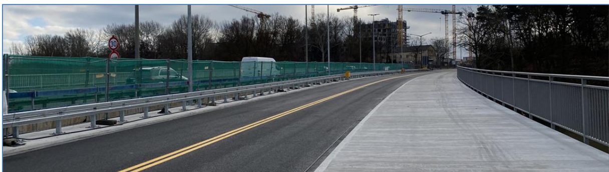
Die Rad- und Gehwege der Gustav-Heinemann-Brücke wurden von bisher 2,80 auf 4,80 Meter verbreitert
