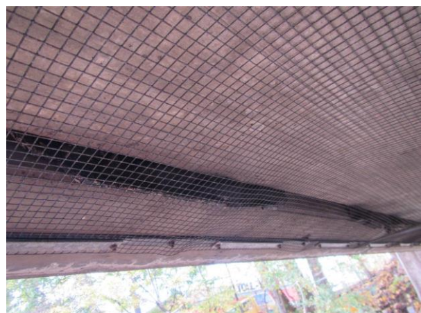
Bild 5: Mit Schutznetzen gesicherte Kragarme
