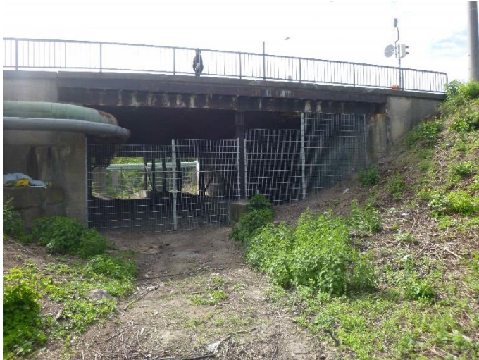
Bild 2: Eingehautes, freigeschnittenes Bauwerk
