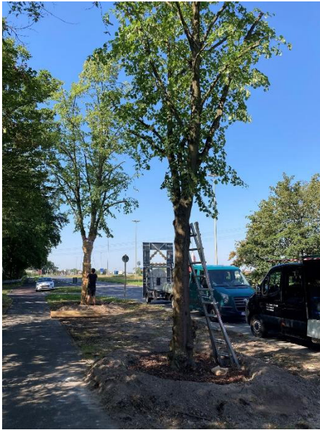
Bild 8: Vorbereitung der Großbaumverpflanzung in Finkenbrunn: Schnittmaßnahmen
