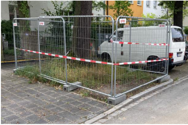
Bild 10: Schutz der bodenoffenen Fläche
