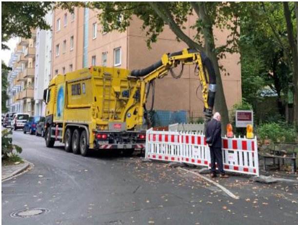
Bild 12: Durch Erkundung: Wurzelsondierung
