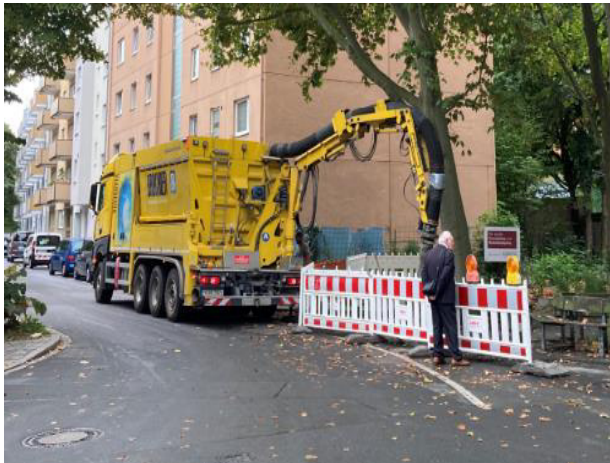
Bild 12: Durch Erkundung: Wurzelsondierung
