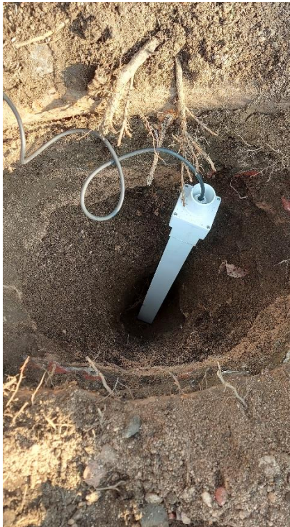
Bild 10: Einbau des Bodenfeuchte-Sensors zur Messung des Wassergehalts
