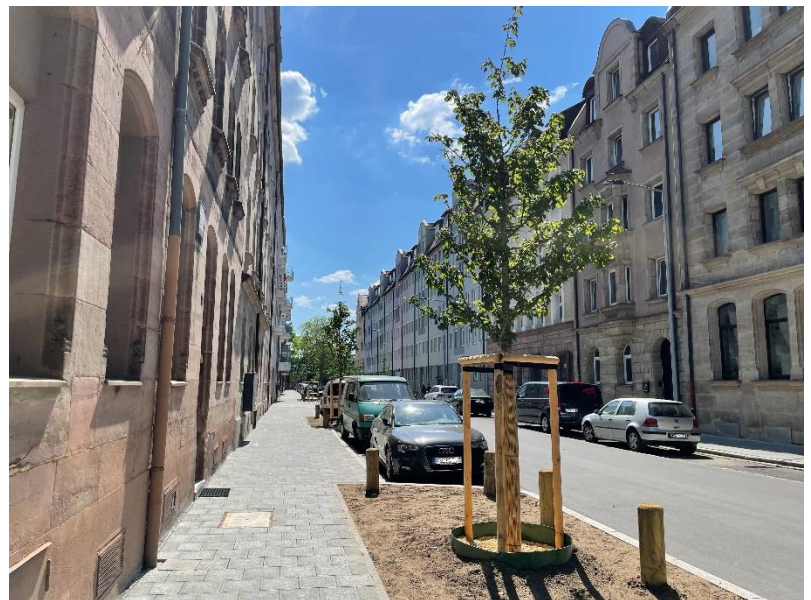
Bild 15: In der Murrstraße wurden im Rahmen der Sanierung 8 neue Baumstandorte geschaffen
