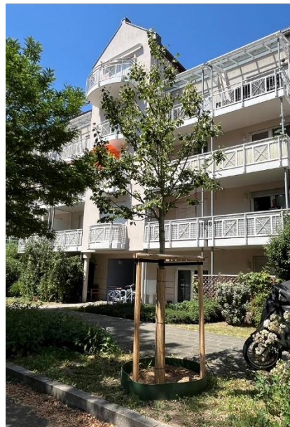
Bild 4: Eine von vier Baumpflanzungen in der Kaepfelstraße
