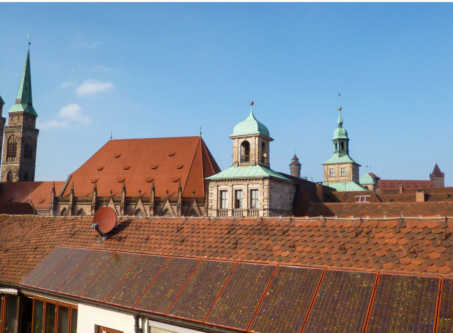
Ensemble Altstadt – Innenhof Neues Rathaus: farblich angepasste PV-Anlage dachintegriert
