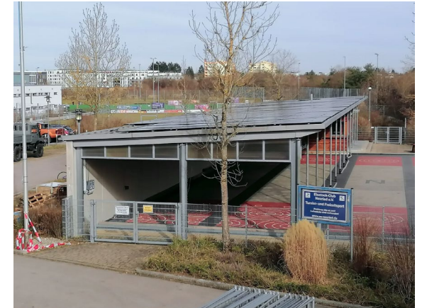
Neuried Sportpark Eisstock Projekt Art: Volleinspeisung Nennleistung: 72 kWp
