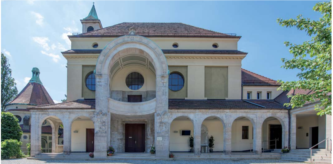
Der heutige Zustand der Ostfassade des zentralen Krematoriumsgebäudes auf dem Nürnberger Westfriedhof. Auf den Frontseiten der beiden Pfeilerstreben des Haupteingangs sind die von Philipp Kittler (1861–1944) gestalteten Figurengruppenreliefs zu erkennen. In der linken Bildhälfte ist noch der Abschluss des ehemaligen Glockenturms zu sehen sowie der obere Gebäudeteil des mittlerweile außer Betrieb genommenen Kolumbariums. Foto Stadtarchiv Nürnberg: Fabian Bujnoch, 19.7.2018. (StadtAN A 96 Nr. 4946)
