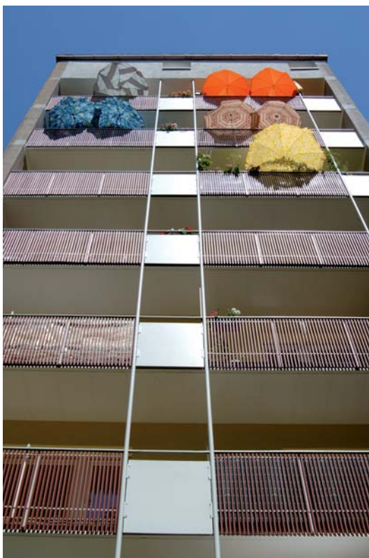
Bunte Sonnenschirme beleben die karge Fassade eines Mietshauses in der Oppelner Straße in Langwasser. Foto Herbert Liedel, 2011. (StadtAN A 104 Nr. 62)
