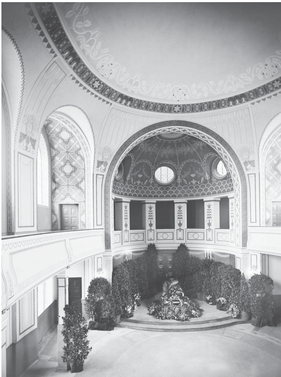
Blick von der Empore der Gedächtnishalle des Nürnberger Westfriedhofs auf die Apsis mit der Sargversenkungsvorrichtung mit einem darauf aufgebahrten Sarg und reichem Blumenschmuck. Foto Hochbauamt, 1914. (StadtAN A 38 Nr. D-161-3)
