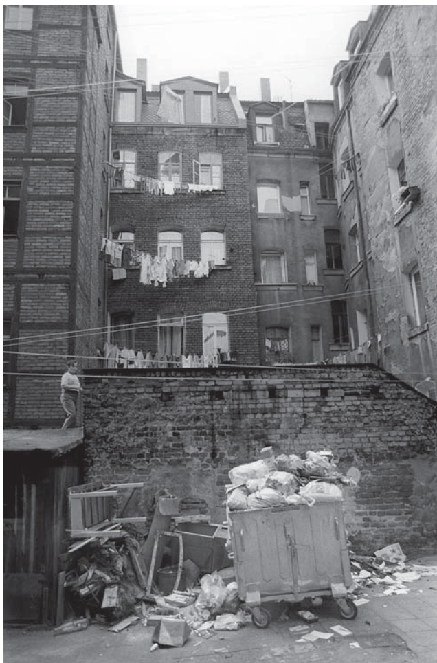
Triste Hinterhofsituation in Gostenhof vor der Sanierung. Foto Herbert Liedel, 1975. (StadtAN A 104 Nr. 1)
