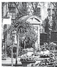
Die Ebnergruft. Foto (Detail) Hochbauamt, 26.4.1928. (StadtAN A 38 Nr. A-9-13)
