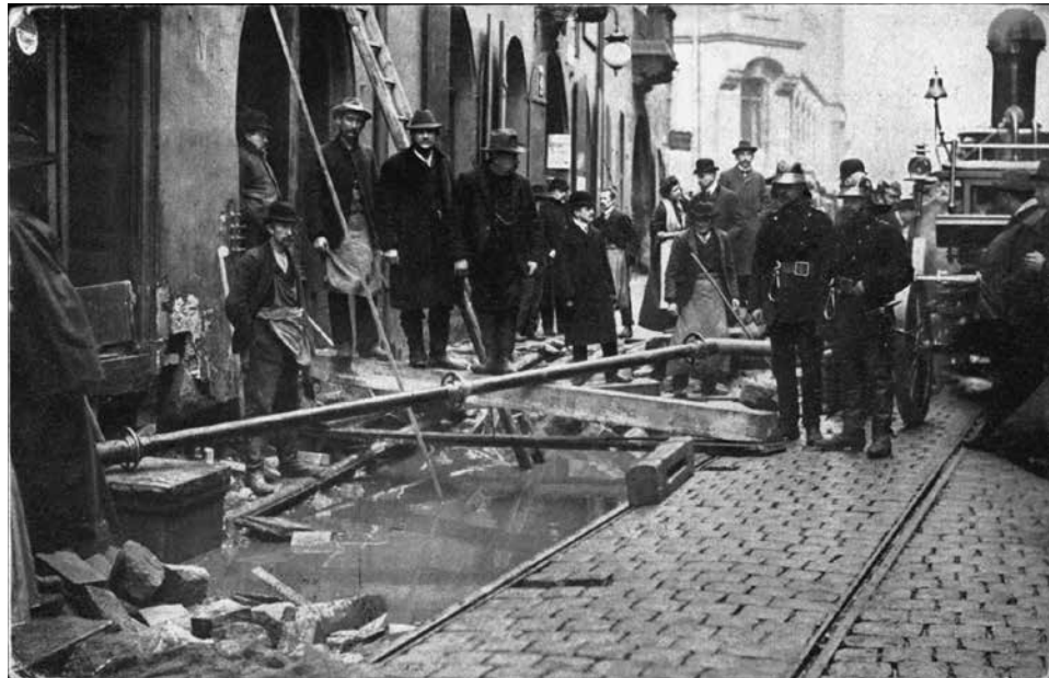
Reparaturarbeiten in der Winklerstraße, Postkarte 1909. (StadtAN A 34 Nr. 3686)
