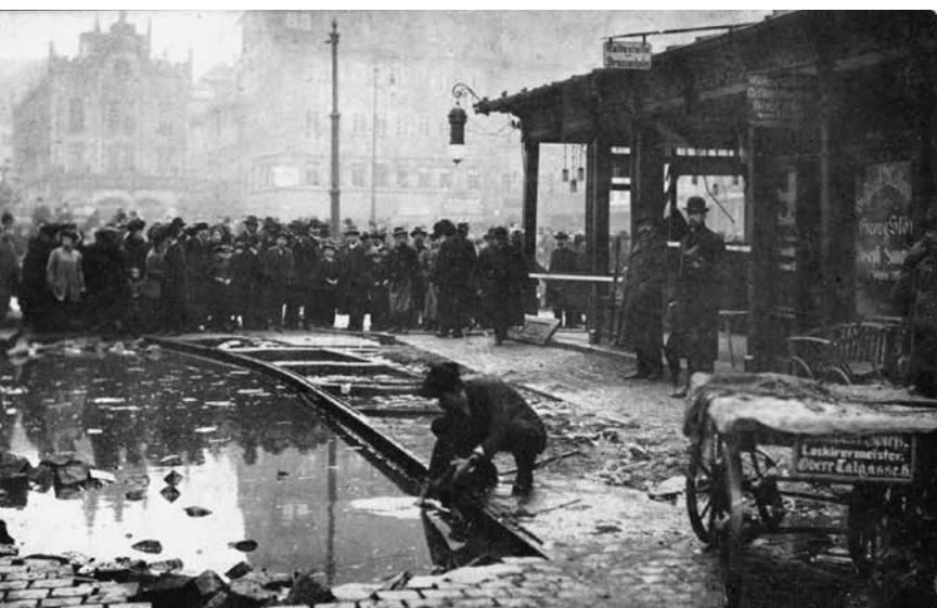
Zerstörte Straßenbahnschienen in der Tuchgasse nach Abfließen des Wassers, Postkarte 1909. (StadtAN A 34 Nr. 3728)
