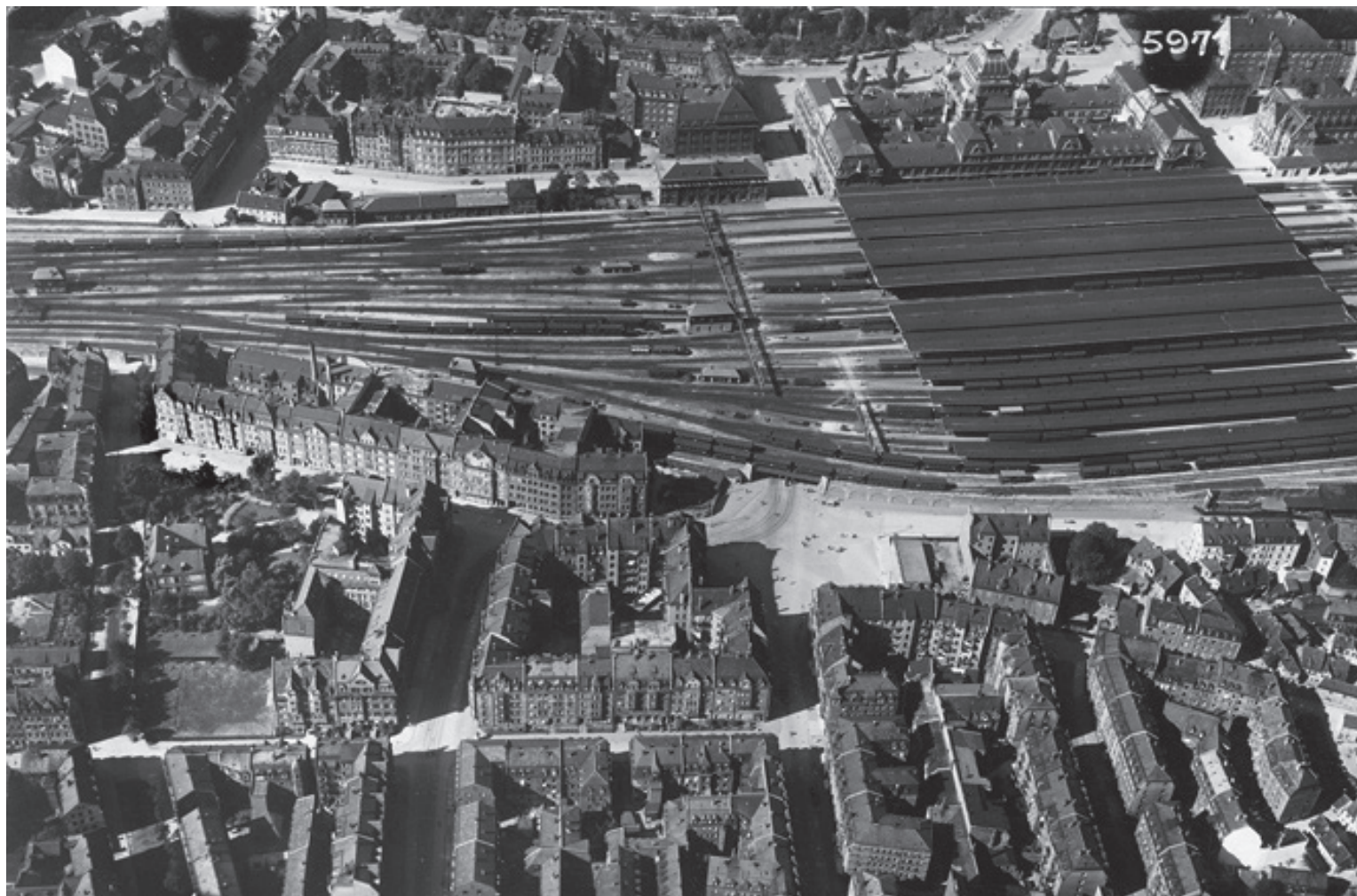
Nürnberg mit seiner Lage im Zentrum Mitteleuropas war ein wichtiger Verkehrsknotenpunkt. Diese Luftaufnahme aus dem Jahre 1927 zeigt eindrucksvoll, dass der Gleiskörper am Hauptbahnhof bereits seine heutige Ausdehnung besaß. (StadtAN 1927-5971)
