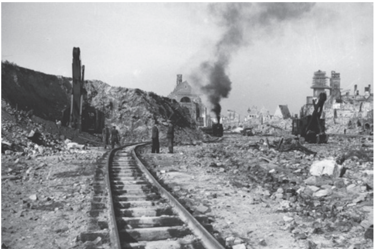
Die so genannte Trümmerbahn, die aus Feldeisenbahnen, wie sie z.B. in Bergwerken oder als Werksbahnen verwendet wurden, hervorgegangen war, machte es wie in über 20 anderen deutschen Städten möglich, binnen kurzer Zeit den Schutt aus der kriegszerstörten Altstadt hinaus zu schaffen. Fotos 1950. (StadtAN A76-RF-019-F2-35; A 39-Fi-H-92)
