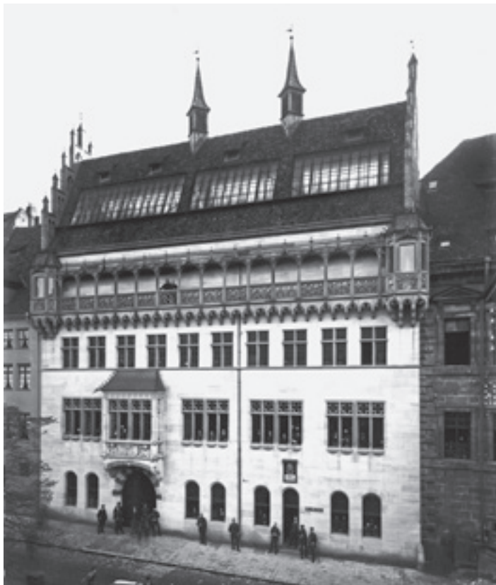
Fassade des Galeriebaus an der Theresienstraße. Foto von Ferdinand Schmidt, 1896/97. (StadtAN A 47 Nr. KS-33-3)
