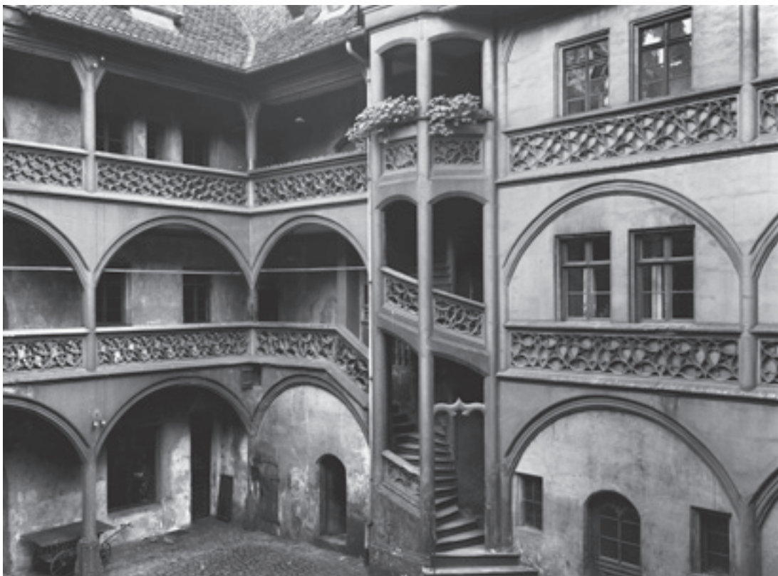
Der Innenhof in der Theresienstraße 7 mit Blick auf den Treppenturm, 1913. (StadtAN A 48 Sc-63-34)
