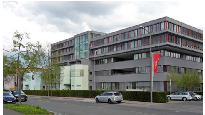
Neubau Bankgebäude und Sanierung der Grundig-Türme
