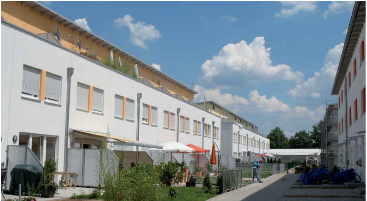
Neubebauung auf dem ehemaligen Schlachthofareal.
