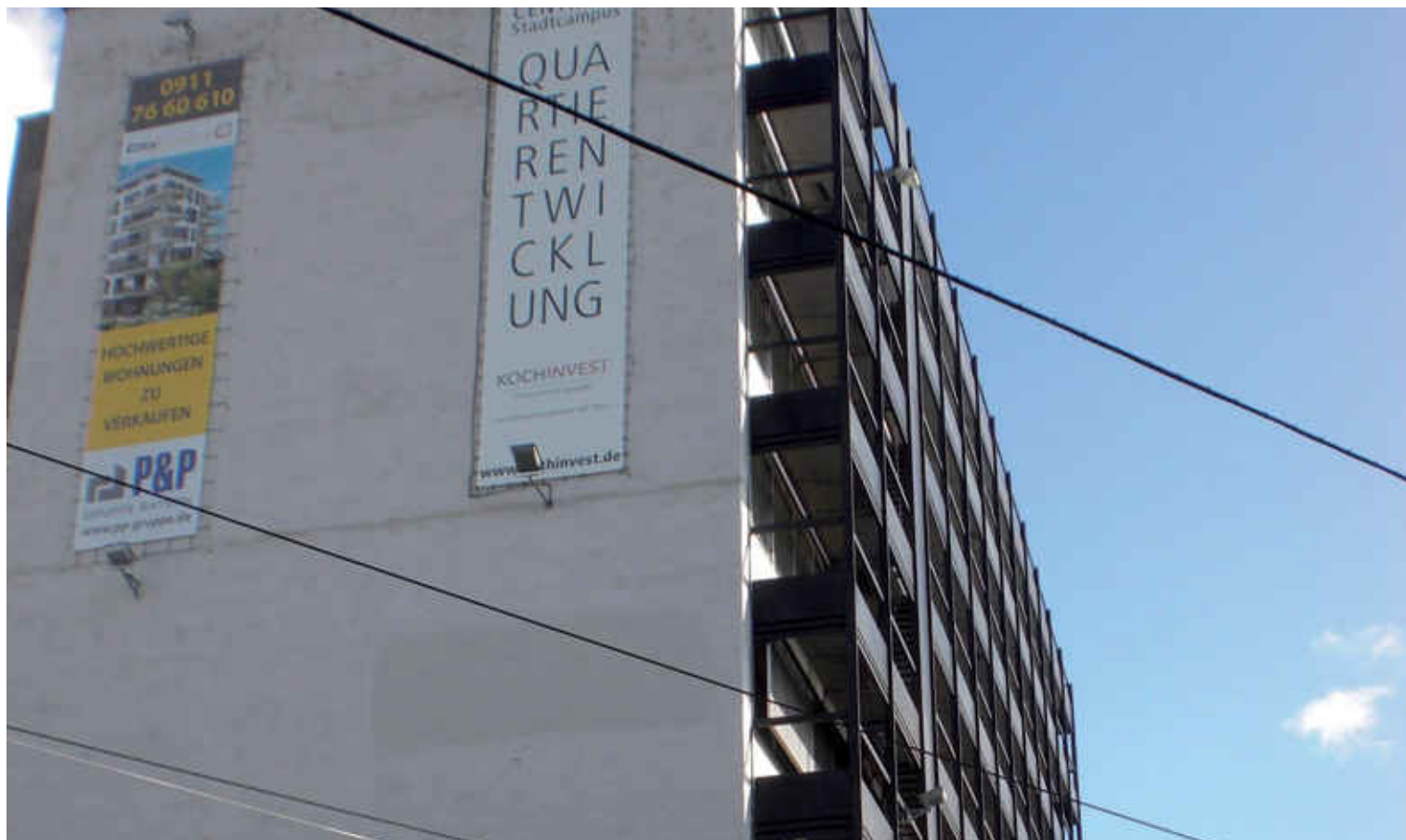
Stadtumbau auf dem Heumann-Areal.
