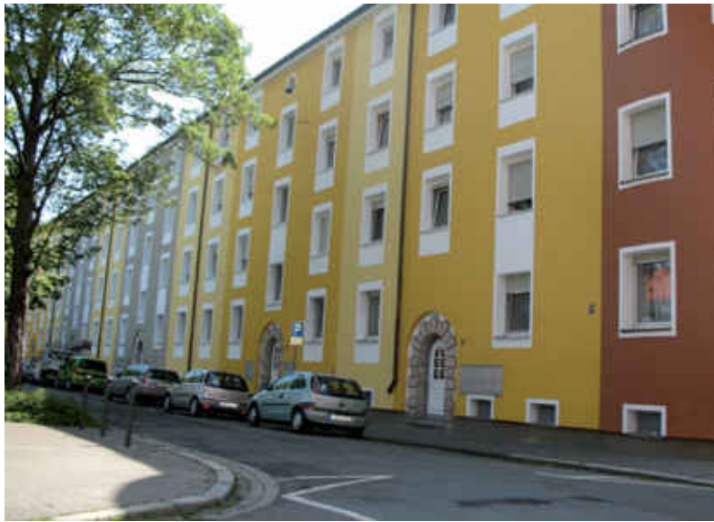
Sanierte Nachkriegszeitbebauung in Hummelstein.
