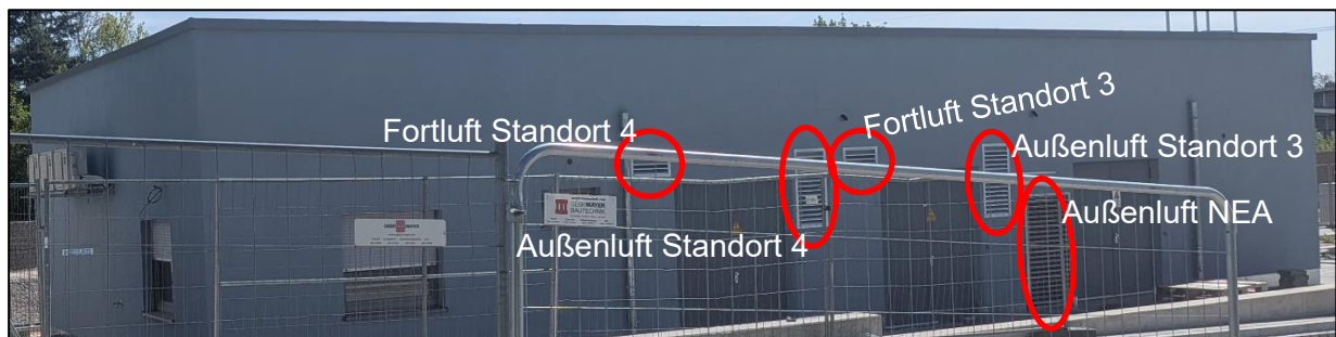
Abbildung 1. Nordfassade Unterwerk mit Lüftungsöffnungen
