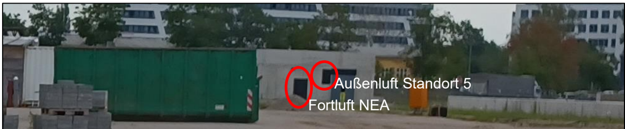
Abbildung 3. Westfassade Unterwerk mit Lüftungsöffnungen
