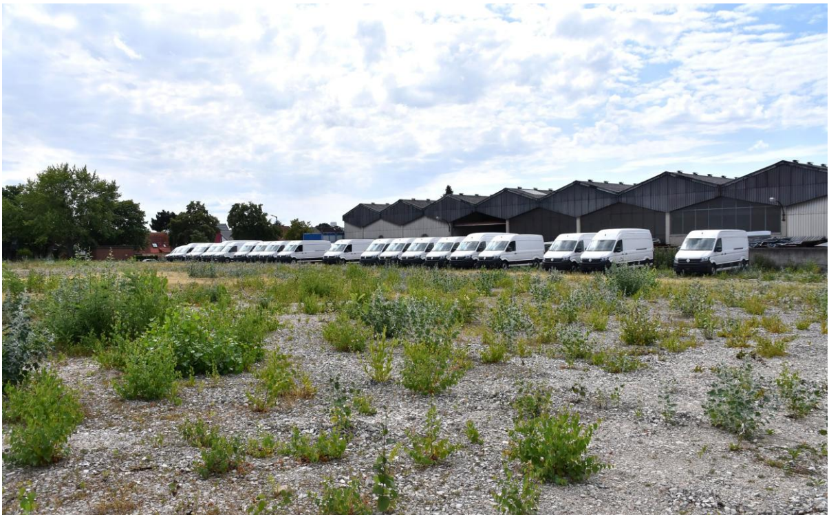
Abb. 9: Schotterfläche des Hallenrückbaues im Westteil des UG (Foto FEHSE 16.07.2023)
