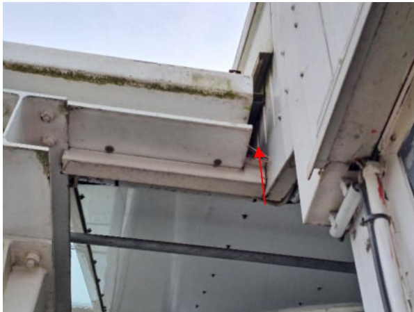
Foto 1: Nistplatz am ehemaligen Realgebäude im Eingangsbereich
