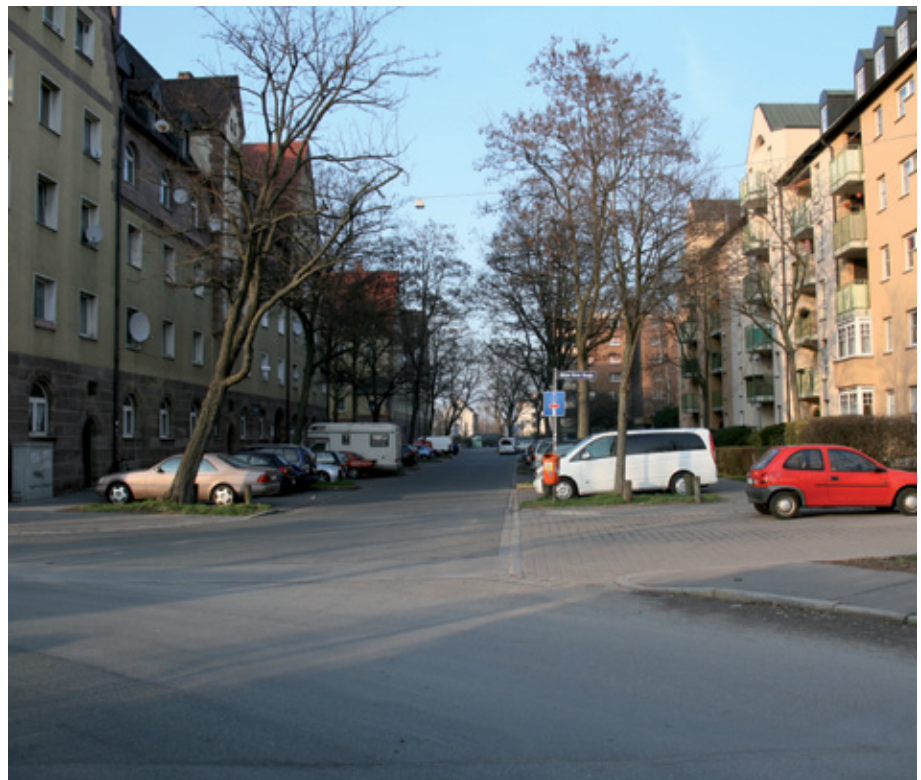
Geschosswohnungsbau in Gostenhof-West.
