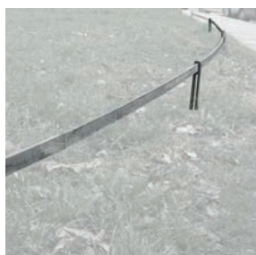
Rabattengeländer, Flachstahl, feuerverzinkt Bestand erhalten
