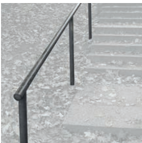
Handlauf aus Stahl, Rundrohr 50 mm
