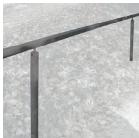
Handlauf aus Stahl, Rundrohr 50 mm, feuerverzinkt
