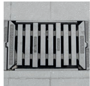
Straßeneinlauf eckig, Gusseisen 300 x 500 mm nach DIN 19594 oder 500 x 500 mm nach DIN 19571 bzw. DIN 19583
