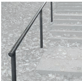
Handlauf aus Stahl, Rundrohr 50 mm
