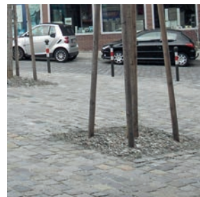
Gepflasterte Baumscheibe mit Gießrand aus Granit oder Kalkschotter, \leq 1 \text{ m}^2
