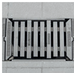
Straßeneinlauf eckig, Gusseisen 300 x 500 mm nach DIN 19594 oder 500 x 500 mm nach DIN 19571 bzw. DIN 19583
