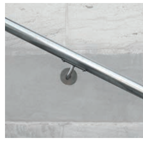
Handlauf aus Edelstahl, Rundrohr nur für Sonderstandorte
