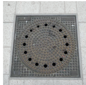
Schachtabdeckung, rund oder eckig, Gusseisen Abdeckungen aus Gusseisen in Pflasterflächen
