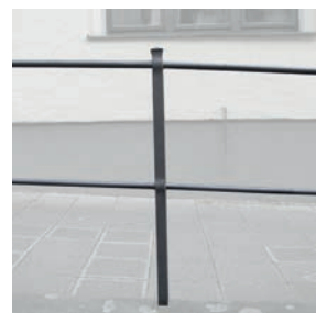
Geländer aus Gusseisen, zwei- strebig, Pfosten mit Durchstoß
