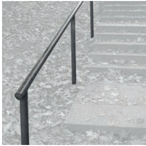
Handlauf aus Stahl, Rundrohr 50 mm
