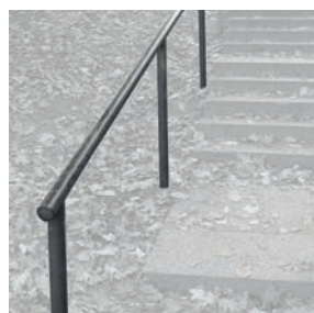
Handlauf aus Stahl, Rundrohr 50 mm
