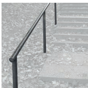
Handlauf aus Stahl, Rundrohr 50 mm
