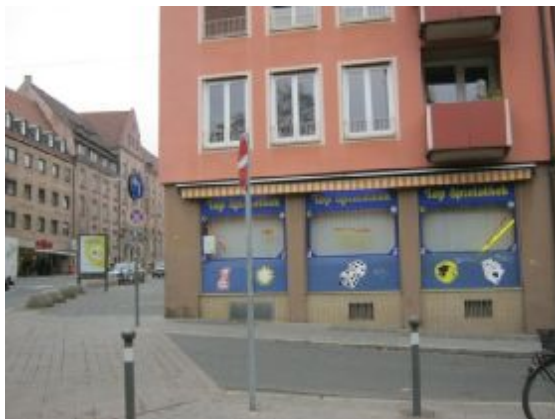
Foto 37: Äußere Laufer Gasse 2
