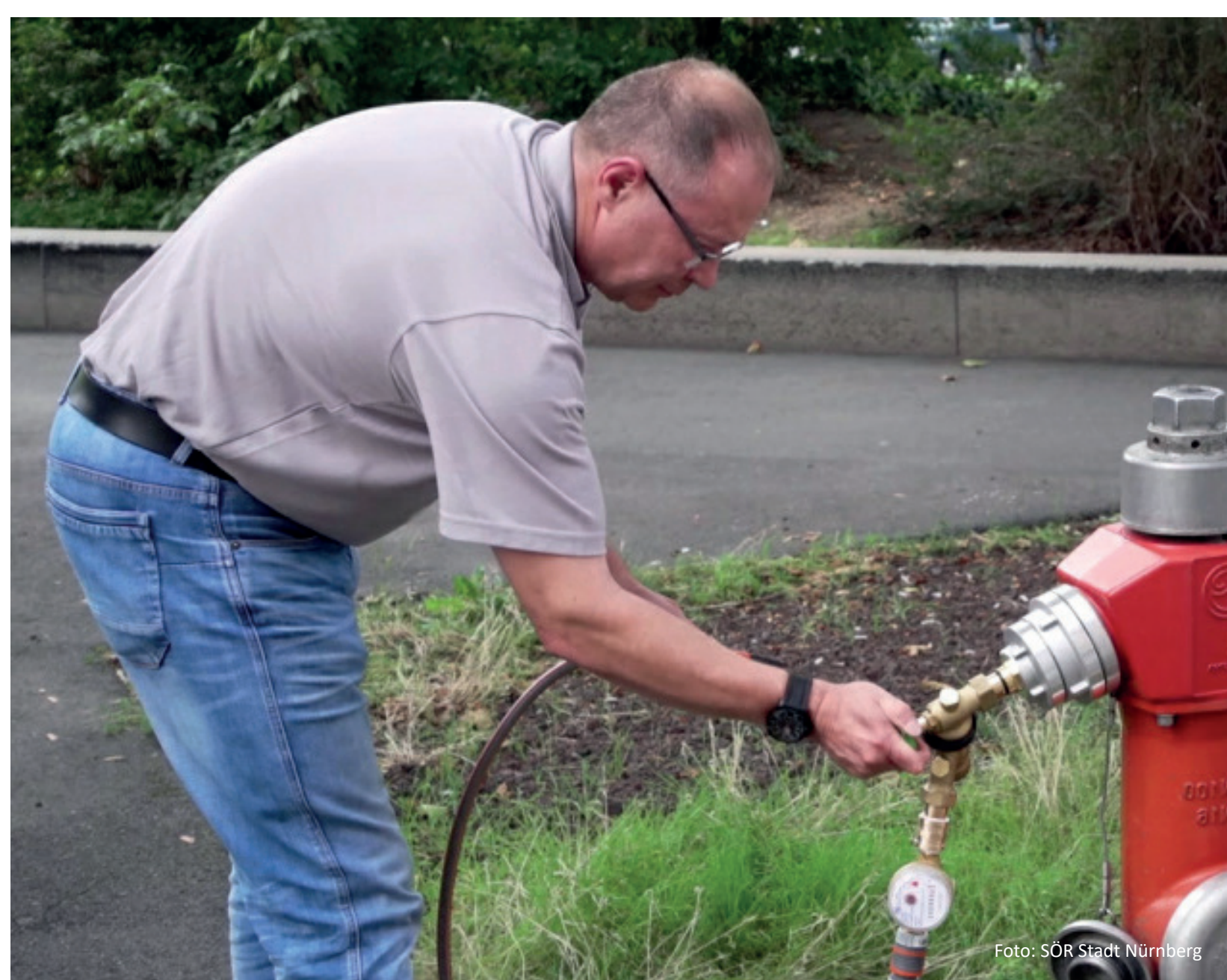
Wasserentnahme am Hydranten
