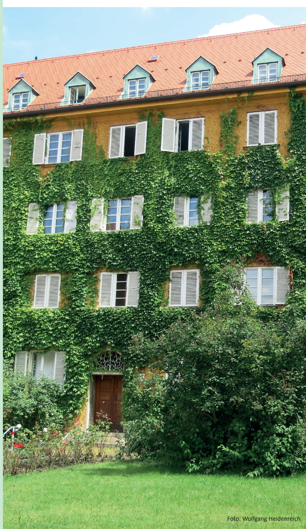
Links: flächiger Bewuchs ohne Kletterhilfe, rechts: leitbarer Bewuchs mit Kletterhilfe
