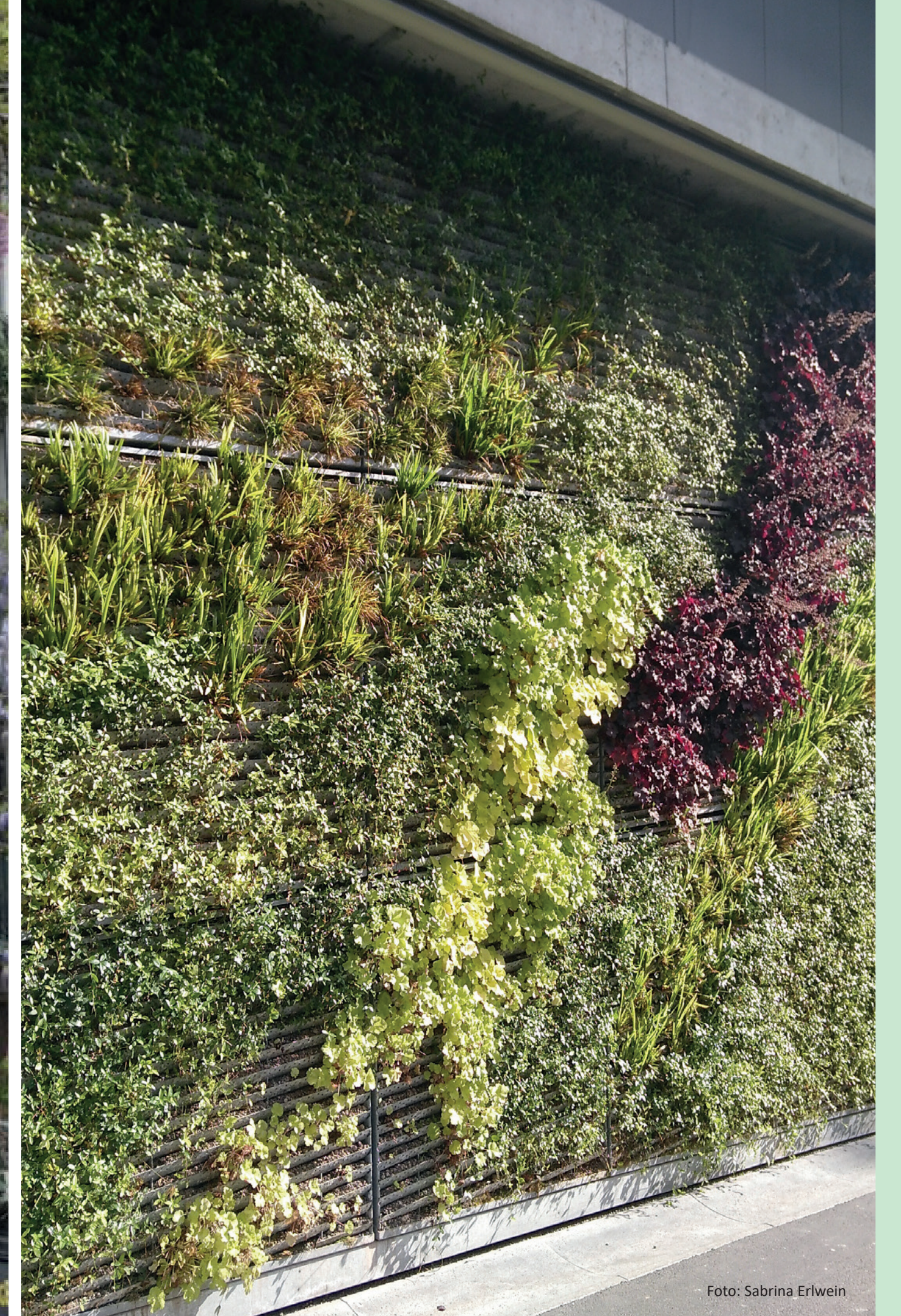
Links: Wandgebundene Fassadenbegrünung mit Pflanzkästen, rechts: flächiges Trägersystem
