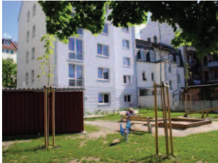
Der Neubau Schloßstraße 57
