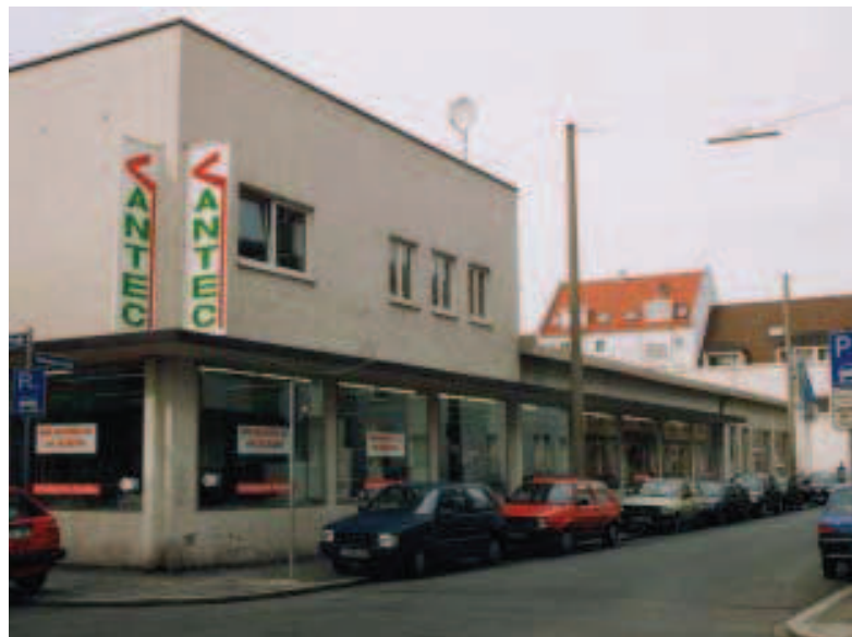
Areal Peter-Henlein-Straße/ Siebenkeesstraße/ Bogenstraße vor dem Umbau
