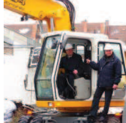
Die Abbrucharbeiten beginnen.
