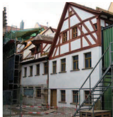
Kühnertsgasse 18-22 während der Bauphase 2006
