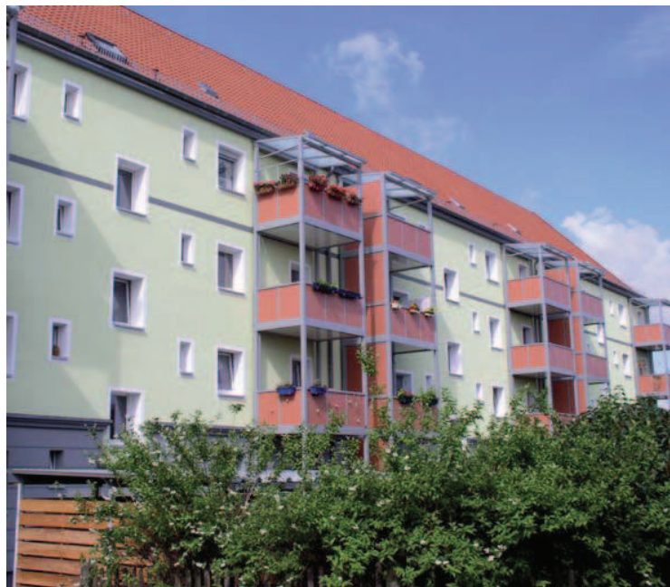
Burgerstraße 35-55 mit neuen Balkonen und Außenanlagen
