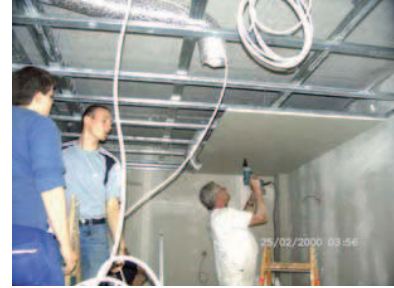
Innenausbau der Cafeteria
