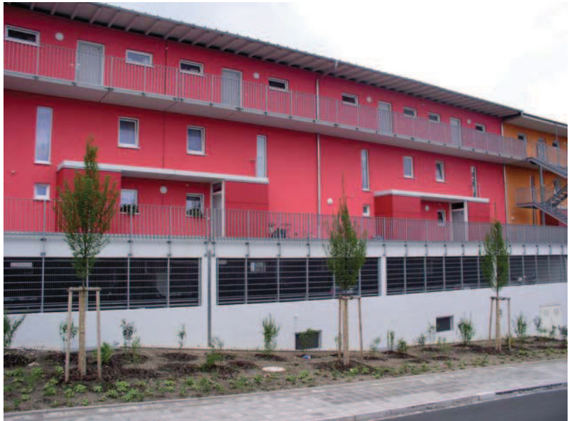
Lärmschutzbebauung zur Bahn entlang der Bürgerstraße
