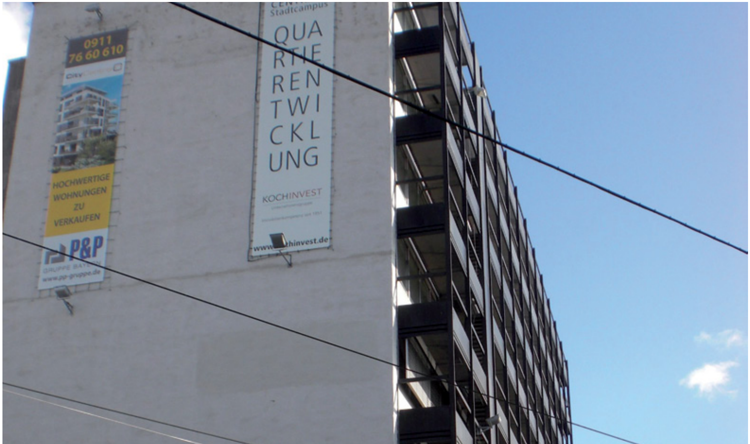
Stadtumbau auf dem Heumann-Areal.
