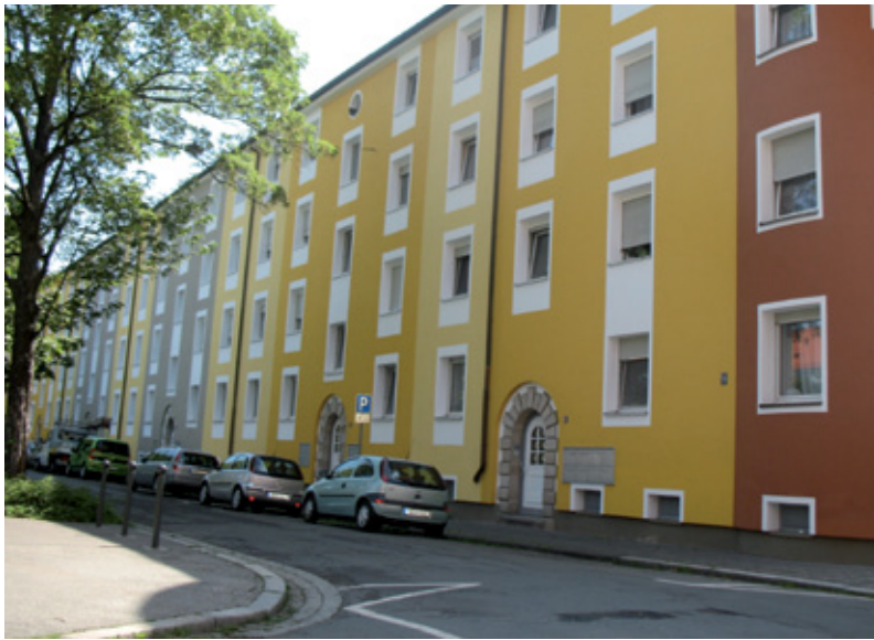
Sanierte Nachkriegszeitbebauung in Hummelstein.
