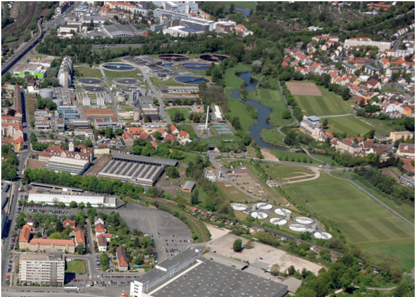
Klärwerk 1 in Doos.
