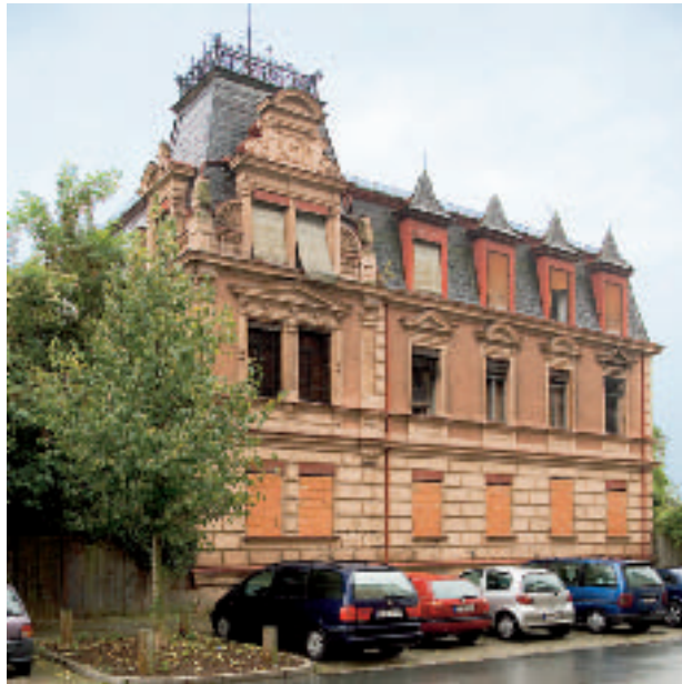
Verfall der ehemaligen „Fabrikanten-Villa“ von 1887...
