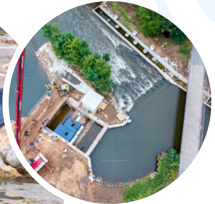
Ein Autokran hat im Juni 2021 die drei Rampen des „Wave Shapers“ eingehoben.
